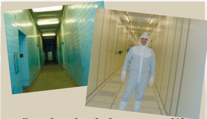
Чистый коридор с двойным полом на ОАО «Авангард», г. Санкт-Петербург: было и стало. Проект ООО «Инвар-проект», в настоящее время – ООО «Чистые технологии»
