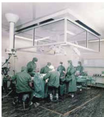
Система ультрачистого воздуха с однонаправленным потоком и одеждой из материала для чистых помещений
