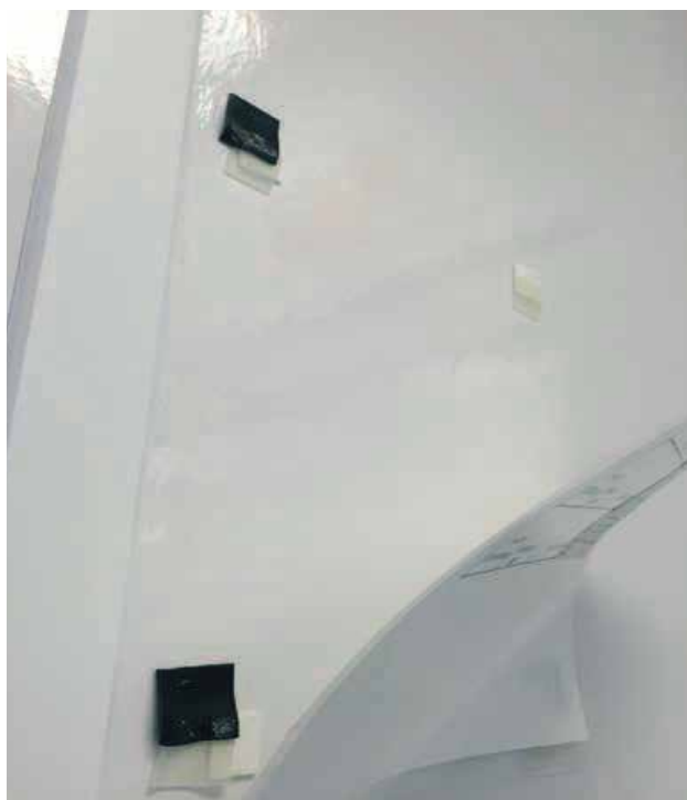
Рис. 1. Двусторонняя липкая лента на поверхностях чистого помещения класса 7 ИСО
