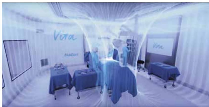
Рис. 2. Иллюстрация потоков воздуха в операционной Halton VITA OR Space
