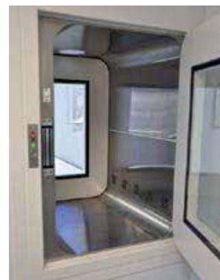
Рис. 2. Простая передаточная камера с двумя дверями
