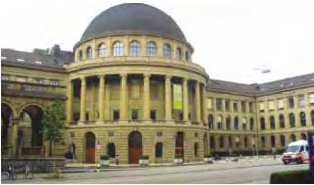
Главное здание Высшей технической школы в Цюрихе
