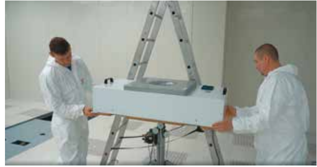
Рис. 10. Электроподъемник для монтажа ФВМ с фильтром снизу
