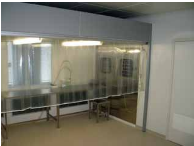
Рис. 1. Чистое помещение (ООО «Диамед», г. Москва), ламинарная зона (зона А) в окружении зоны В
