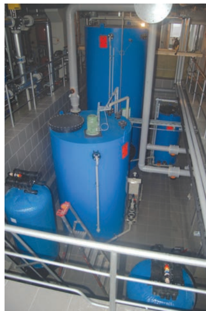
Рис. 7. Система нейтрализации жидких стоков
