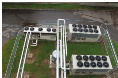
Рис. 5. Чиллеры системы утилизации вторичного тепла
