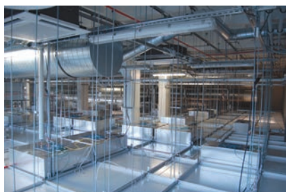
Рис. 6. Комплекс кондиционирования и распределения по рабочим зонам обеспыленного воздуха
