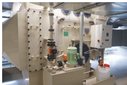
Рис. 8. Скруббер системы нейтрализации газообразных выбросов
