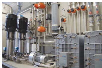
Рис. 4. Система подготовки и распределения деионизованной воды
