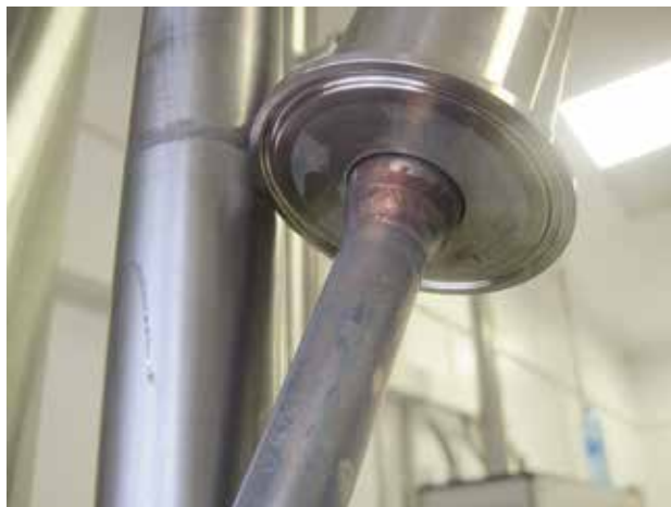
Рис. 2. Датчик уровня в емкости Воды для инъекций со следами ржавчины
